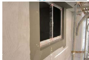
窗框結構體第二道防水
