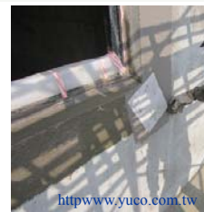
角隅不織布補強，防止裂縫滲水
