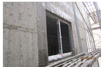
窗框結構體第一道防水
